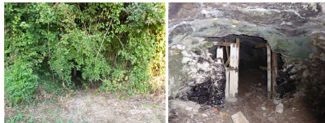
Entrée de la carrière située sur la route d'Ars près de la parcelle 1AUB et de l'emplacement réservé n°4
